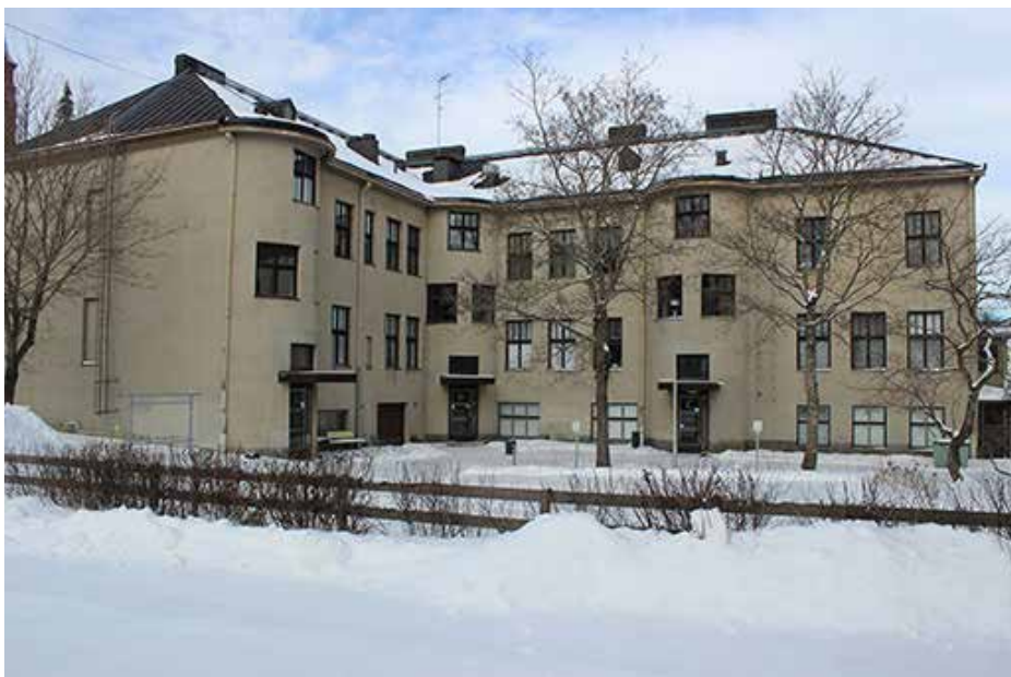
Kuvassa Graniittitalo kuvattuna etelästä vuonna 2017.
